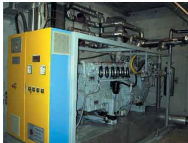
Das **Blockheizkraftwerk (BHKW)** dient der wirtschaftlichen und umweltfreundlichen Gewinnung von Strom und Wärme aus dem anfallenden Faulgas der Schlammfanganlage.
