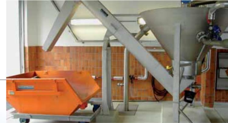
Im **Sandfang** - erfolgt die Abtrennung der im Abwasser enthaltenen Schwerstoffe (Sand, Streusplitt und dergl.) durch Sedimentation.
