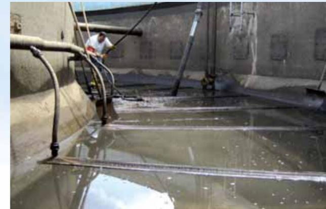
Über die Belüftungsmembrane in den Belebungsbecken erfolgt die gleichmäßige und feinblasige Einbringung des Luftsauerstoffs von den Druckluftgebläsen in das Abwasser.
