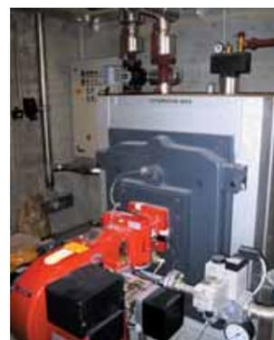
Über die **Biogaskesselanlage** wird das im Faulturm anfallende Klärgas thermisch verwertet und für die Beheizung des Faulturms, der Raumheizung und der Warmwasseraufbereitung verwendet.
