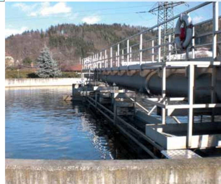
In den **Nachklärbecken** erfolgt die Sedimentation des Belebtschlammes aus dem biologisch gereinigten Abwasser.
