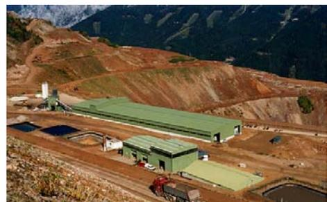
Die bei den Zersetzungsprozessen in der Deponie entstehenden Gase werden abgesaugt und bei Temperaturen von über 1000 Grad Celsius umweltschonend verbrannt.
