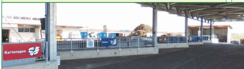
Sägezahn-Rampe im regionalen Altstoffsammelzentrum (ASZ) in Ratschendorf
