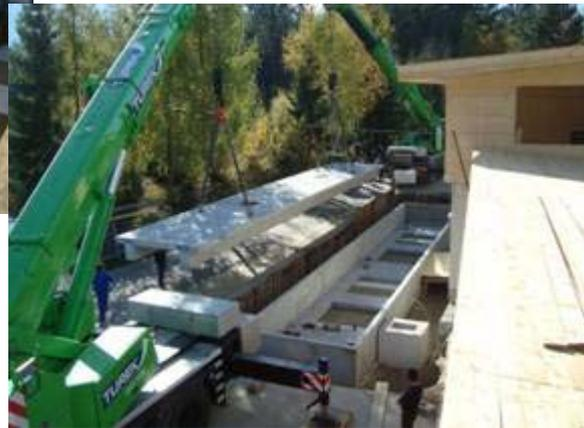
Mit der neuen, 18m langen Waage können LKW-Sattelschlepper in einem Wiegevorgang gewogen werden.
