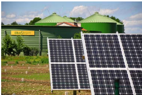
ÖKO-Strom aus Mureck
